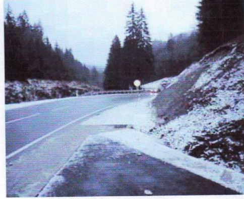
منعطف داخلي وجوانب حفر
