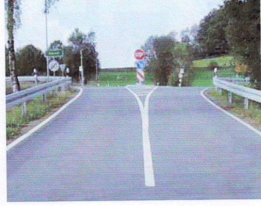
بعد بناء الجزيرة الموجهة وتغيير اللوحة أصبح التقاطع أكثر وضوحاً
