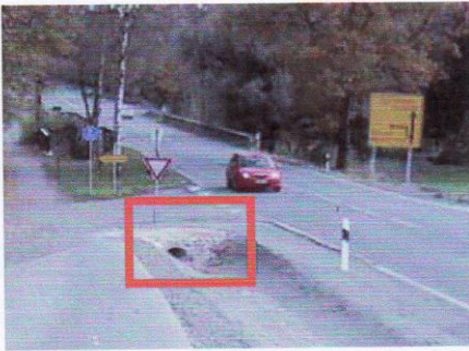
عبارة أنبوبية مع قطعة رأسية عمودية كعائق للسيارات المنحرفة عن الطريق
