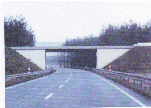
جدار الجسر في مجال المنعطف الداخلي
