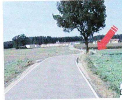
حقيقة يختبئ خلف القوس الشاقولي المحدب منعطف متعكس نصف قطره صغير
