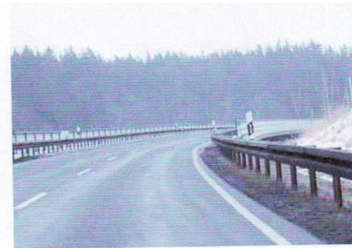
تجهيزات حماية ودرابزين في مجال المنعطف الداخلي
