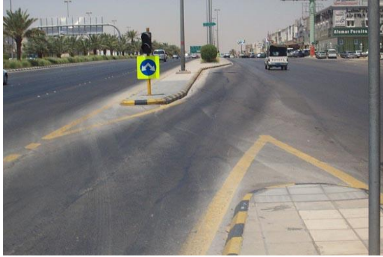
الشكل رقم (2-3-29). فتحة ذات تصميم هندسي مناسب (عرض مناسب أكبر من 3.2 م و مسارات تسارع وتباطؤ وعلامات أرضية)
