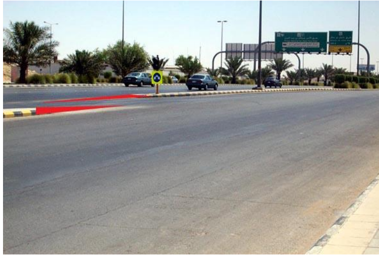
الشكل رقم (2-3-36-ب). فتحة خروج بعد معالجتها بمد طرفي الجزيرة لفرض استخدامها للخروج فقط "بعد"
