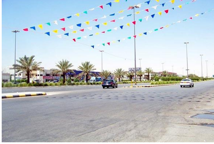
الشكل رقم (2-3-34). فتحة واسعة تربك مناورة الحركة ولا تنظمها.
