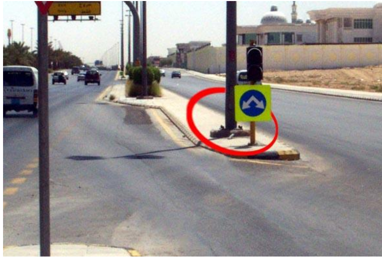
الشكل رقم (2-3-37). عمود ائارة في موقع قريب من الصدم ويشكل خطورة بالغة.
