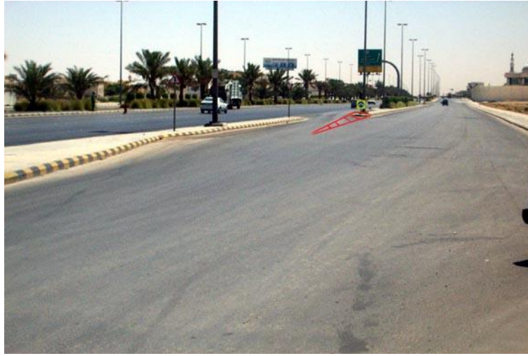
الشكل رقم (2-3-35-ب). مد أحد طرفي الجزيرة لإلزام السائق على استخدام الفتحة للدخول فقط "بعد"
