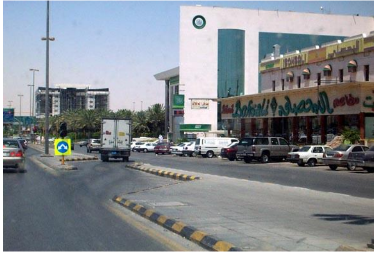
الشكل رقم (2-3-32). معالجة هندسية غير ملائمة ولا تتوافق مع معايير تصميم الفتحات.
