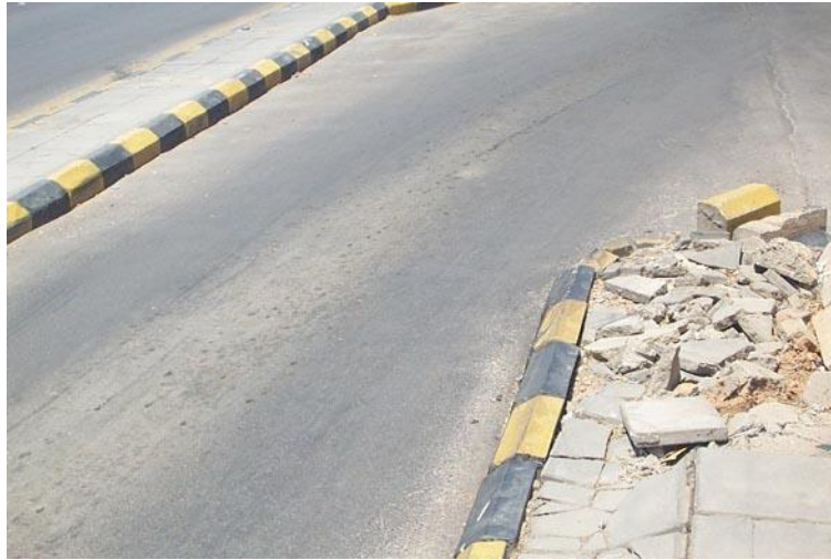
الشكل رقم (2-3-33). المعالجة الهندسية غير المناسبة أدت الى تخريب و انهيار في الجزيرة نتيجة مرور المركبات عليها
