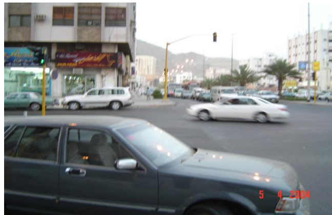
الشكل (2-4-4). تقاطع في مكة المكرمة يتضح الوقوف في زاوية التقاطع وعدم وجود خطوط مشاة.
