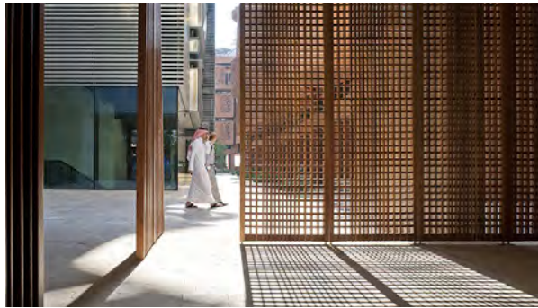
توفر الحواجز الرأسية الظل للمناطق المعرضة لزوايا الشمس المنخفضة، مصدر، أبوظبي
