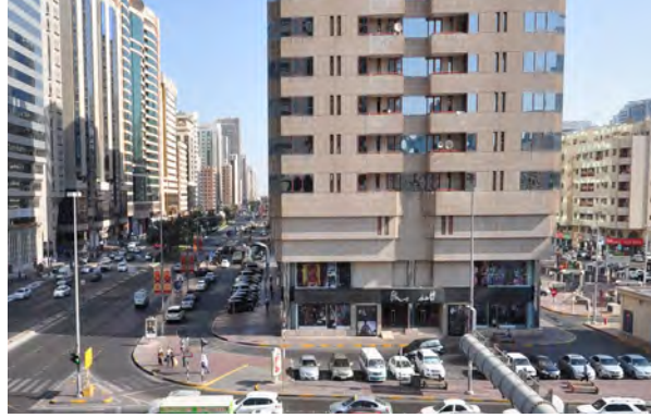
بناء مرتفع متعدد الاستخدامات مع واجهات نشطة ، أمامية ، خلفية و طرفية ، أبو ظبي
