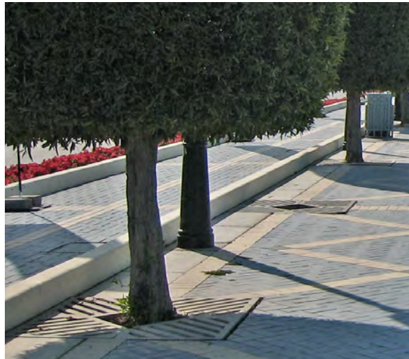
شبكة تصريف المياه للأشجار ، منطقة الكورنيش ، أبو ظبي
