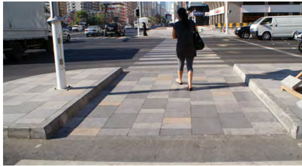
تم تصميم ملتجآت المشاة في الجزيرة الوسطية كمنحدرات وبعرض مساوٍ لمعبر المشاة ، شارع السلام ، أبوظبي
